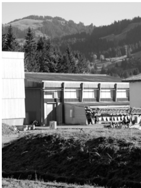
Le nouveau centre de formation.
